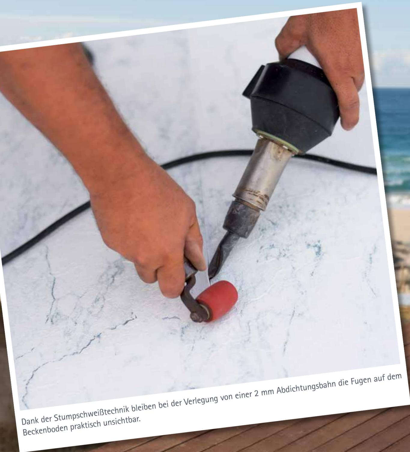
Dank der Stumpfschweißtechnik bleiben bei der Verlegung von einer 2 mm Abdichtungsbahn die Fugen auf dem Beckenboden praktisch unsichtbar.
