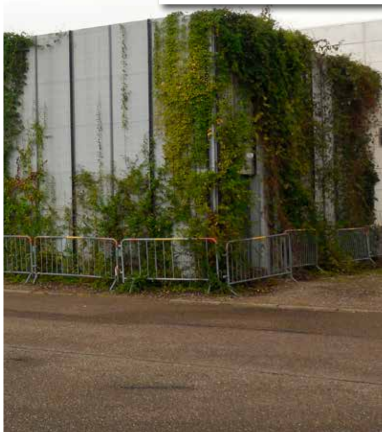
Club Kamikaze – Bélgica Perfis RENOLIT ALKORPLAN Solar como base para uma parede verde.
