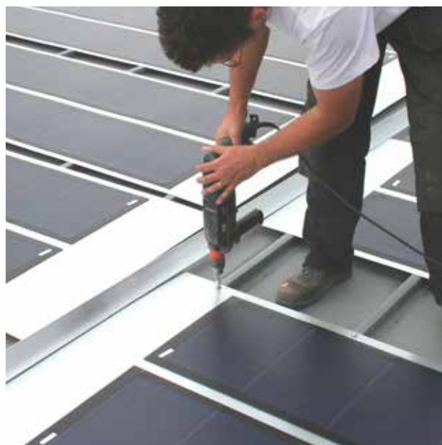
Substituir painéis sem risco de danificar a membrana impermeável.
