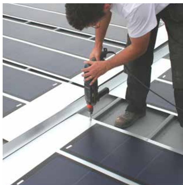
Sostituzione dei pannelli senza rischio di danneggiare le membrane impermeabili.
