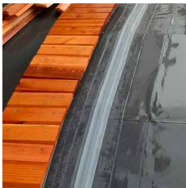
Le doghe di legno sono fissate ai profili RENOLIT ALKORPLAN Solar
