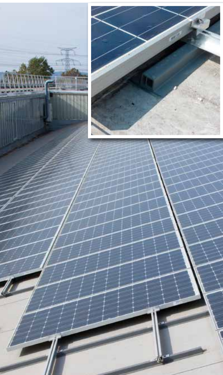
Bâtiment industriel Valéo – France 24 500 m 2 RENOIT ALKORPLAN F + profilés RENOIT ALKORPLAN Solar Crédits photos EDF ENR et Photec
