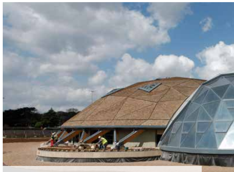
Centre sportif et de loisirs – Royaume-Uni Profils RENOLIT ALKORPLAN Solar utilisés comme base pour la fixation de tuiles en bois de cèdre et de panneaux en aluminium
