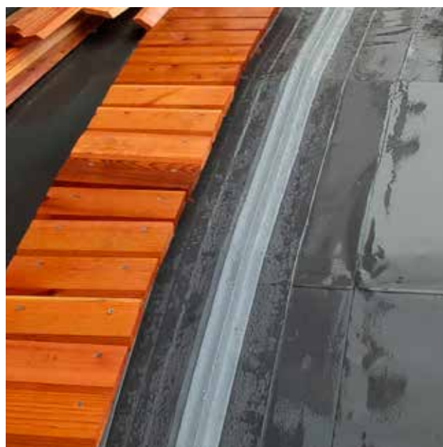
Les pièces d'habillage en bois sont fixées sur des profilés RENOLIT ALKORPLAN Solar
