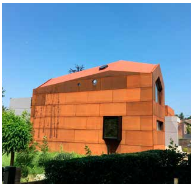
Maison d'architecte - Belgique Membrane en Terracotta combinée à une façade en acier Corten
