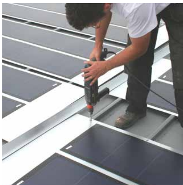
Reemplazar paneles sin riesgo de dañar la lámina impermeable.
