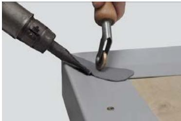
Einen Streifen **RENOLIT** ALKORTOP über dem Ausschnitt des Bleches aufschweißen.
