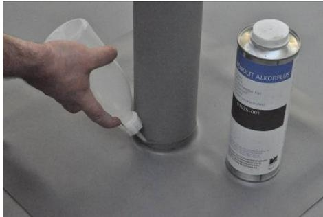
Befestigen Sie die Grundplatte mechanisch und schweißen Sie dann den Flansch aus **RENOLIT ALKORTOP** auf die Dachbahn.
