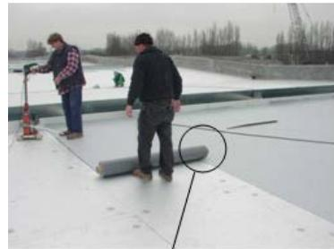
Unabhängig von der Windlastberechnung, **müssen immer mindestens 2 Befestiger je Quadratmeter** verwendet werden. Der Mindestabstand zwischen den Befestigern von 150 mm, muß eingehalten werden.
