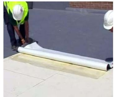
Der Kleber wird genau so auf die andere Hälfte der Rolle aufgetragen.
