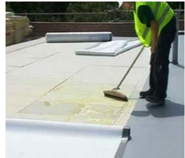
**RENOLIT ALKORTOP A** Dachbahn wird zügig, mit der vlieskaschierten Unterseite, in den frischen Kleber, eingerollt und, beispielsweise mit einem Besen, angepreßt.
