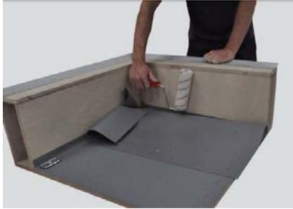
Anschlußbahn in der Ecke so auffalten, daß sich eine Tasche bildet, die wasserdicht von innen nach außen verschweißt wird.
