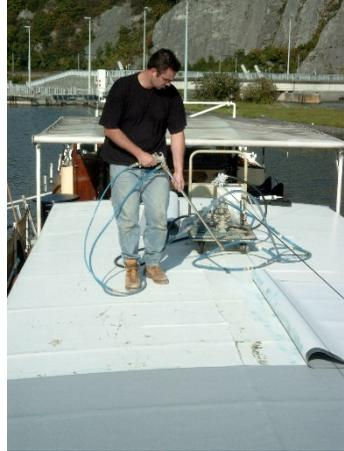
Warten Sie, bis der Kontaktkleber handtrocken ist, bevor die Dachbahn in den Kleber eingelegt und angedrückt wird. Die Trockenzeit hängt von Witterungsbedingungen ab.
