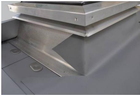
Schneiden Sie die zwei verbleibenden Streifen entlang der dargestellten Linie zu. Dabei lassen Sie ein kleines, halb rundes Stück von etwa 20 mm stehen, um die Ecke dicht verschweißen zu können.
