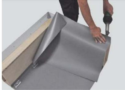
Verschweißen Sie die Anschlußbahn mit der Dachbahn in der Fläche und falten Sie die Folie anschließend zu einer aufrecht stehenden Tasche.
