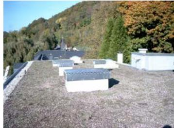
Die Auflastschicht sollte umgehend nach Verlegung der **RENOLIT ALKORTOP L** Dachbahn und der Schutzlage aufgebracht werden, um die Lagesicherheit der Bahn bei Wind zu gewährleisten.
