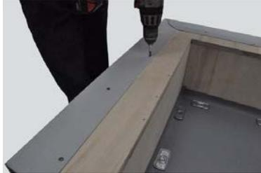
Verbundblech entsprechend der vorgegebenen Eckenform zuschneiden und auf der Unterkonstruktion befestigen.
