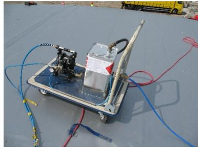
Die Dachbahn wird dann längs hälftig gefaltet, um anschließend den Kontaktkleber mit entsprechendem Sprühsystem aufzubringen.
