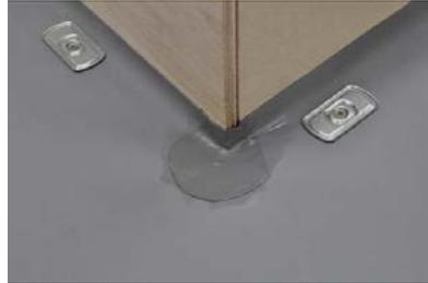
Schneiden Sie einen Streifen **RENOLIT ALKORTOP** derselben Höhe wie der aufgehende Anschluß/Wandanschluß, um die Abdichtung zu gewährleisten + 100 mm für die Überlappung auf die Flächenbahn.
