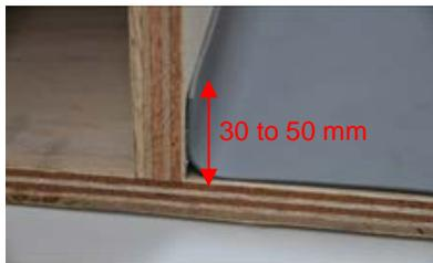
Flächenabdichtung etwa 30 – 50 mm am Anschluß hoch führen und entlang der Außenkante eine Linienbefestigung anbringen.
