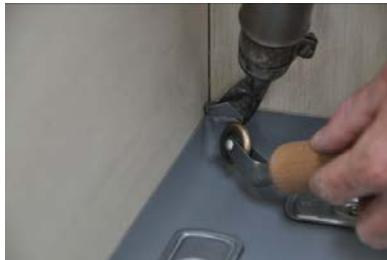
Schneiden Sie einen Streifen **RENOLIT ALKORTOP** derselben Höhe wie de aufgehenden Anschluß/Wandanschluß, um die Abdichtung zu gewährleisten + 100 mm für die Überlappung auf die Flächenbahn.
