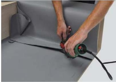
Schneiden Sie die Anschlußbahn so ein, daß sie sich später bis in die Vertikale Innenecke verlegen läßt.
