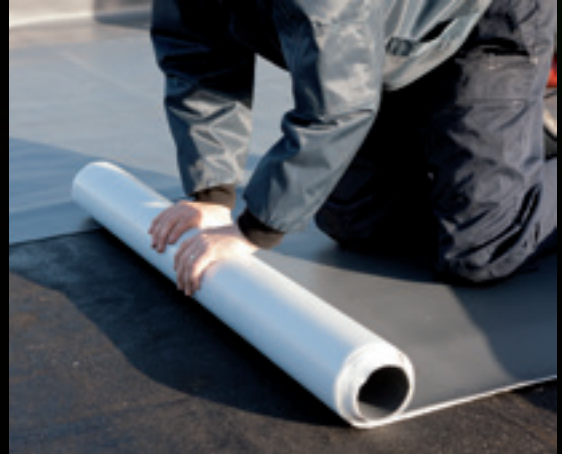
Ausrollen der Bahnen
