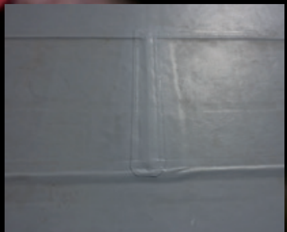
Kopfstöbe mit Streifen unkaschierter RENOLIT ALKORTEC abdecken und zuschweißen.
