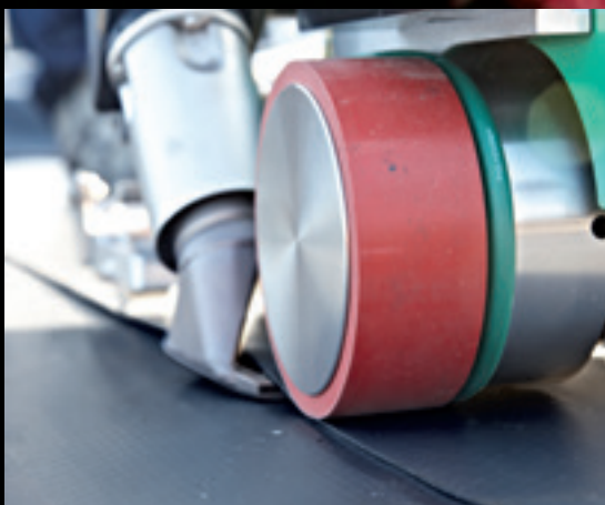
Langsnähte mit Heißluft verschweißen
