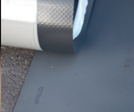
Ausrichten der Bahnen
