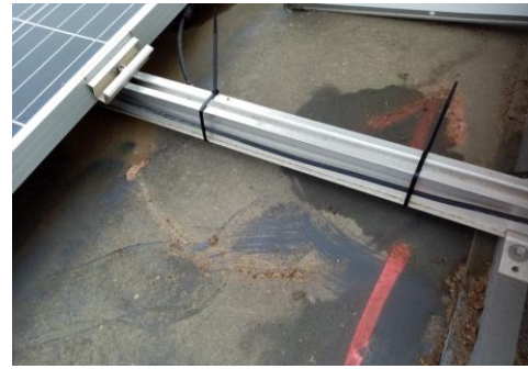
Collier de serrage (type rislan) maintien le cheminement DC du GPV
