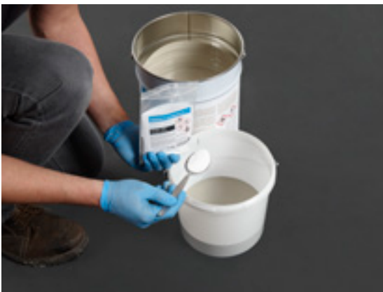
3. Ajoutez la bonne quantité de catalyseur en suivant les instructions sur l'emballage.
