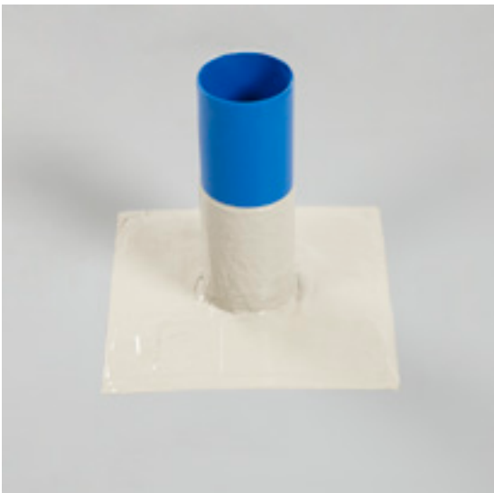
Sellado de una salida de cubierta
