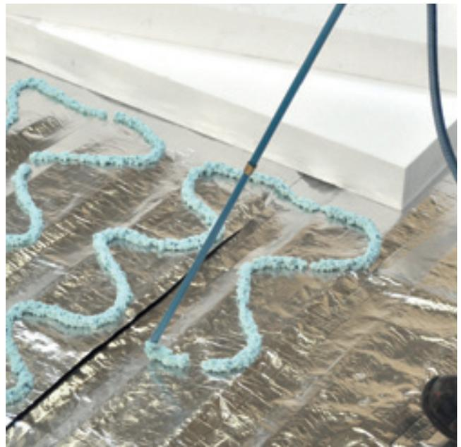
Der RENOLIT DUALFIX Kleber wird mit einer Spritzdüse in Streifen auf dem Dachuntergrund aufgebracht. Die Dämmstoffplatten (EPS, PUR/PIR, Mineralfaser, ...) werden quer über die Rillen gelegt und angedrückt.
