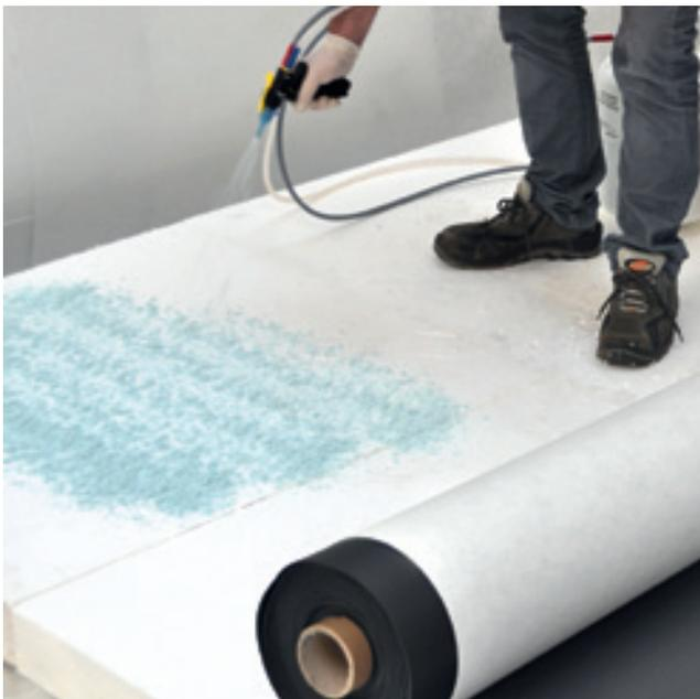
Der RENOLIT DUALFIX Kleber wird mittels einer Spritzpistole dünn und gleichmäßig auf dem Untergrund verteilt. RENOLIT DUALFIX ist kompatibel mit den meisten vlieskaschierten Abdichtungsbahnen. (RENOLIT ALKORPLAN A, ALKORTEC A, ...)
