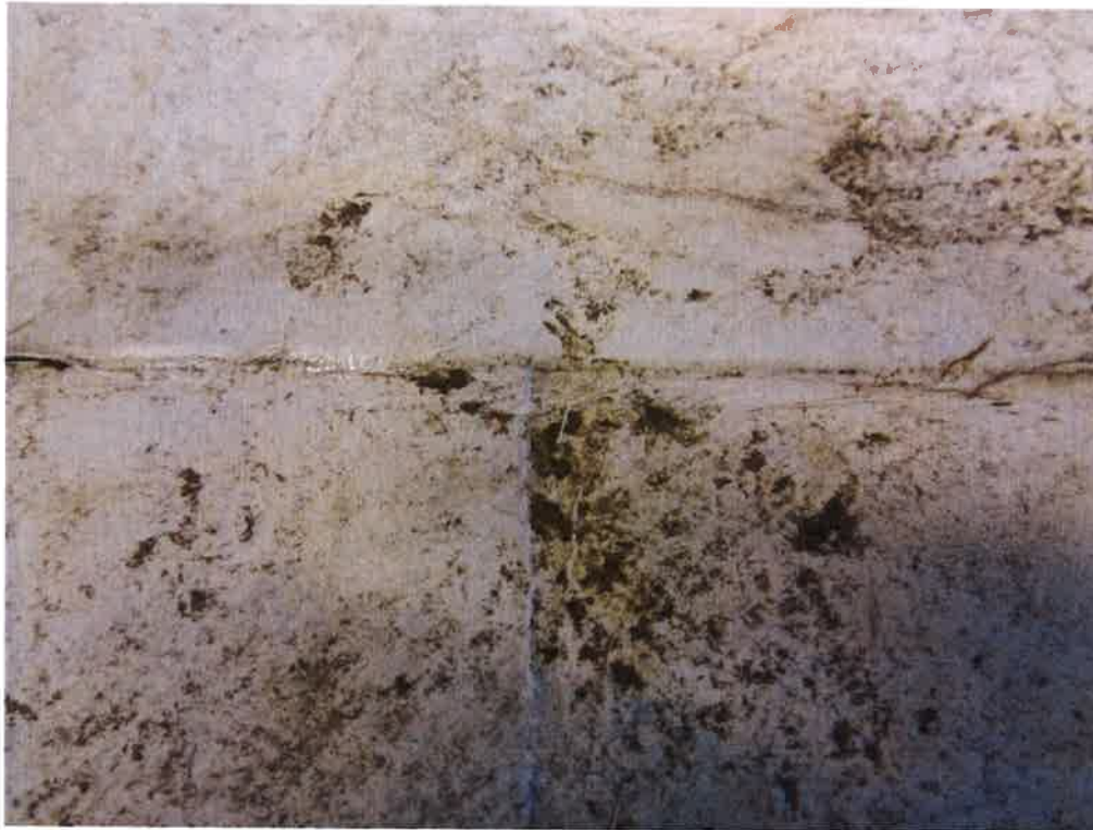
Abbildung 2: Dichtungsbahnoberfläche mit T-Stoß
