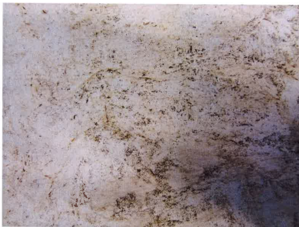
Abbildung 1: Oberfläche der Dichtungsbahn
