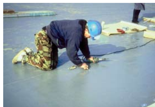
fig. 2: Controla das soldaduras
