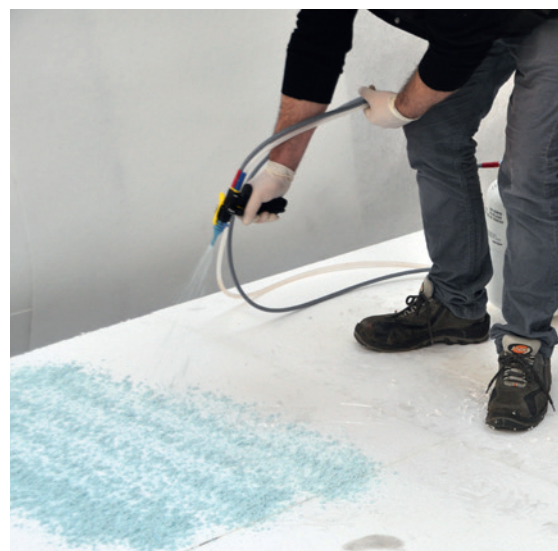
Fig. 2: De RENOLIT ALKORPLUS Dualfix 81065 lijm wordt aangebracht met een spuitpistool.
