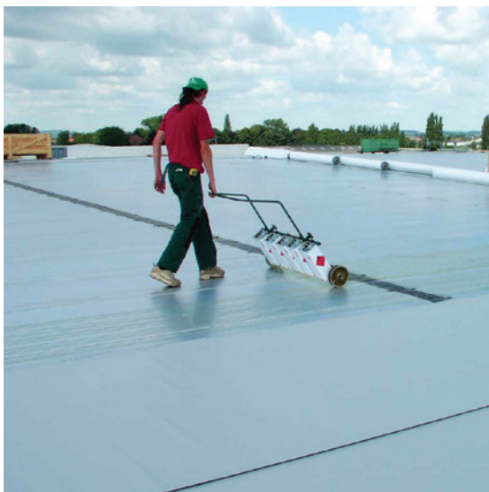
Fig. 1: Aanbrengen van lijm met de rolwagen
