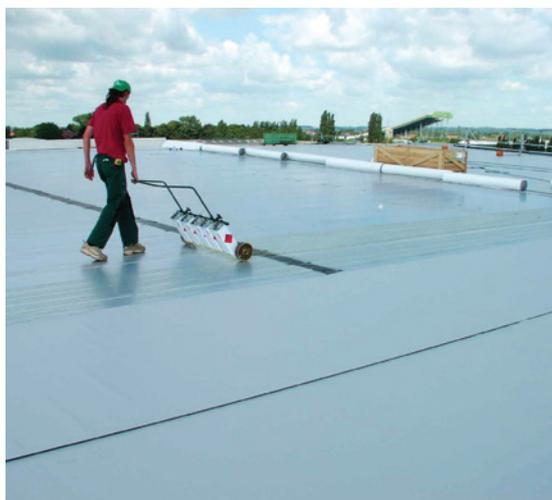
Fig. 1: Mise en place semi-automatique de la colle polyuréthane 81068.
