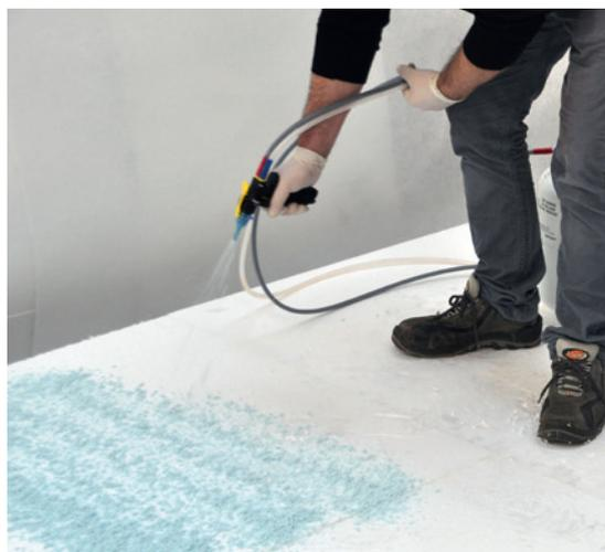
Fig. 2: La colle 81065 est pulvérisée sur le support à l'aide d'un pistolet de pulvérisation.
