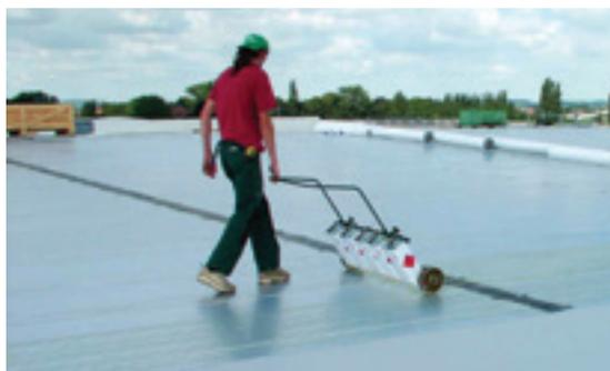
Fig. 1: Verklebung mit dem Auftragswagen
