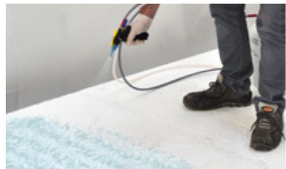
Fig. 2: Der PU Kleber RENOLIT DUALFIX wird mittels einer Spritzpistole verteilt
