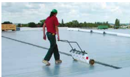
Fig 1 : Applicazione di adesivo RENOLIT ALKORPLUS 81068/81168 con carrello
