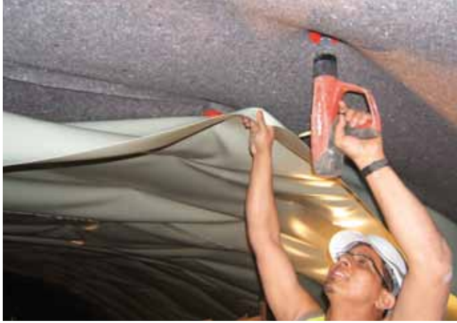
Fixation du géotextile
