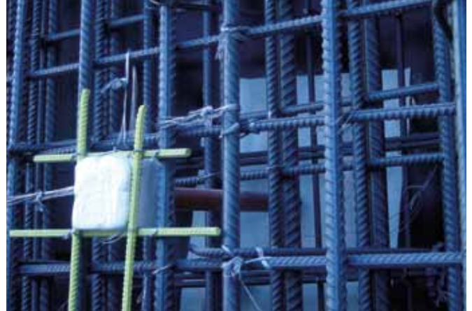
Protection de l'entrée du tuyau d'injection
