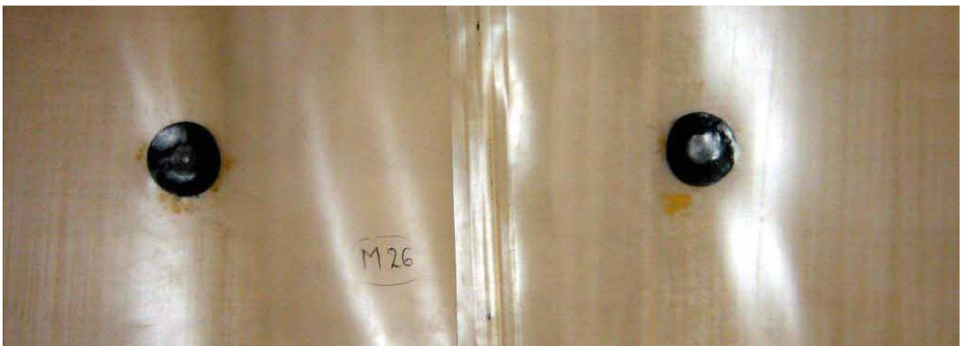
*Fixation de la géomembrane par appareil manuel*
