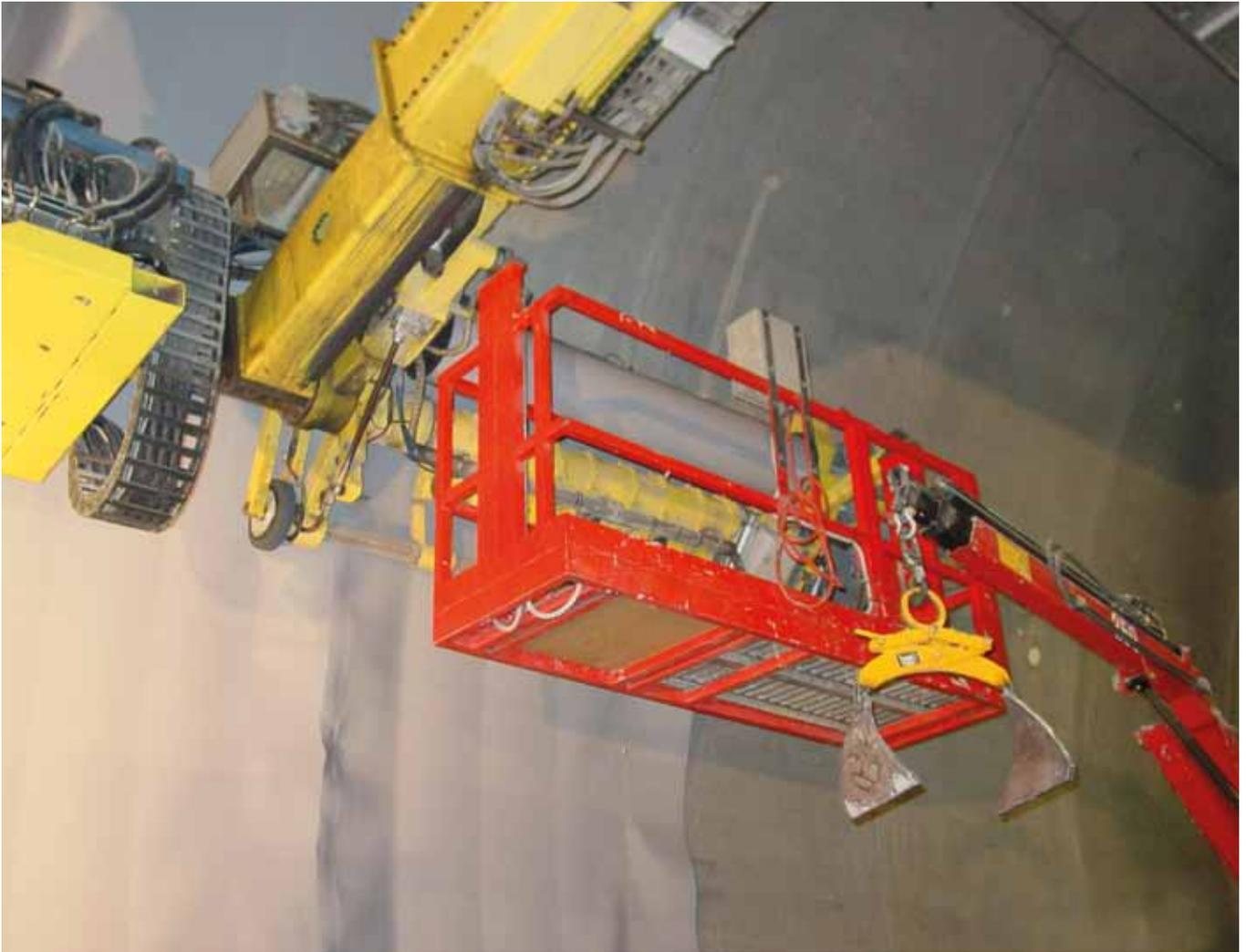
Automate d'installation pour le système collé
