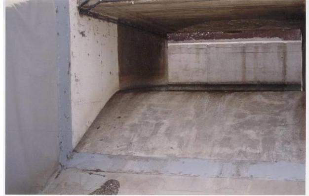
Conexión con la estructura de hormigón con la ayuda de la brida suelta-fix
