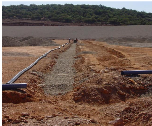
Canalización de drenaje debajo del sistema de impermeabilización
