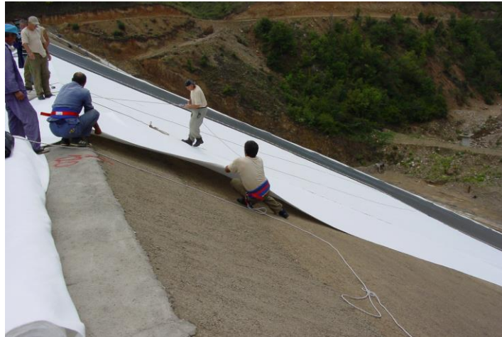
Colocación del geotextil
