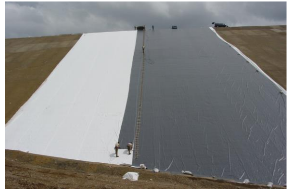
Desenrollado e instalación de la geomembrana
