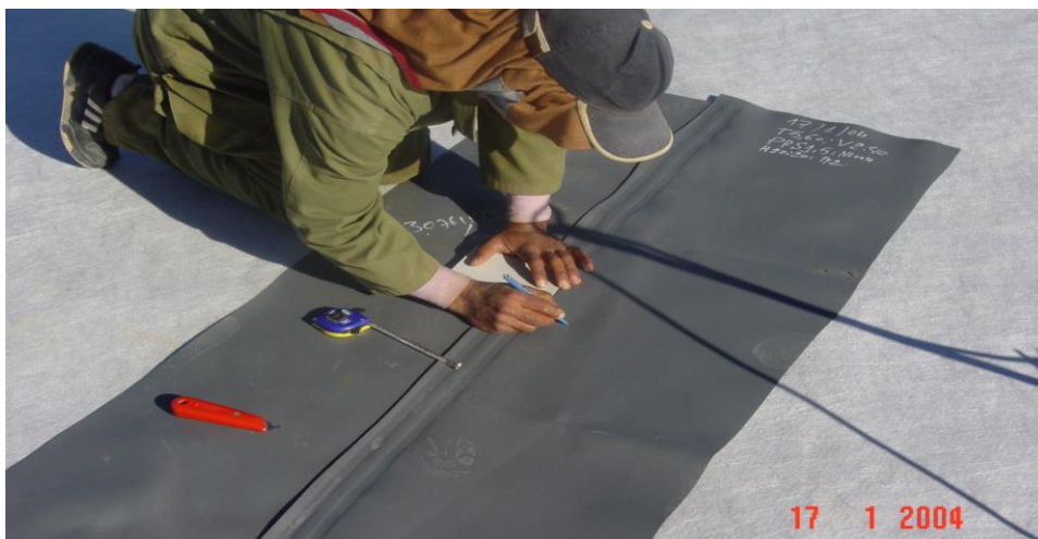
Prueba de soldadura
