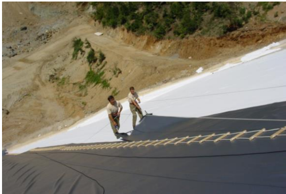
Desenrollado e instalación de la geomembrana
