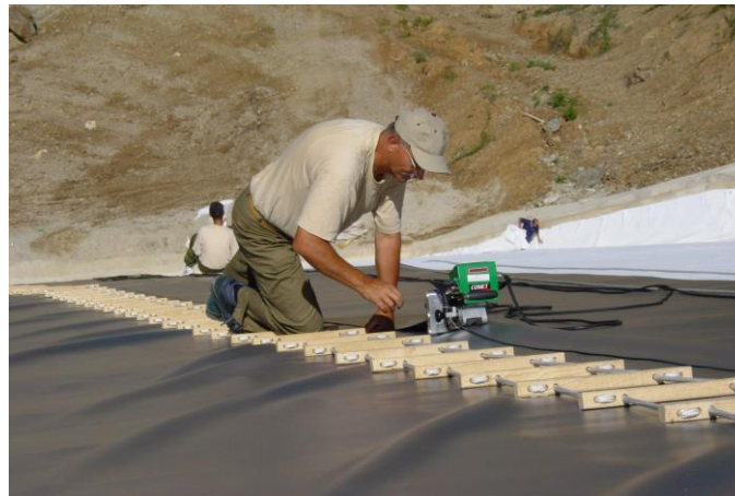
Soldadura con aire caliente y doble solapo
