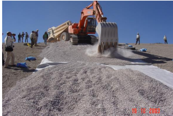
Distribución con excavadora
