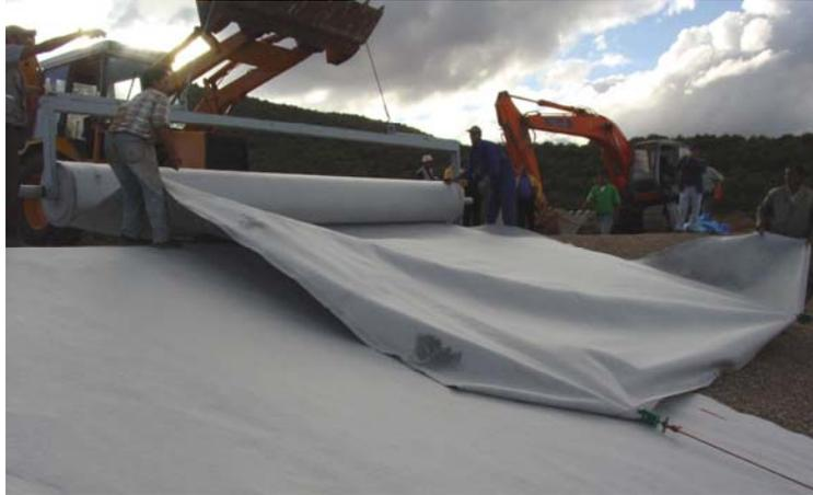
*L'installation de géomembranes avec dispositif de levage*
