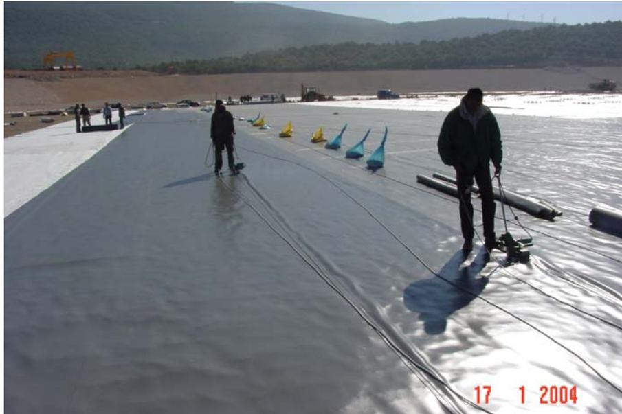
*Soudure de la Géomembrane*
