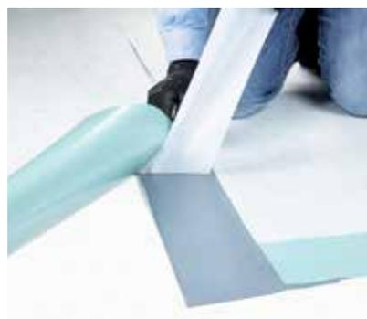
Assemblage par bande adhésive des chevauchements transversaux.
