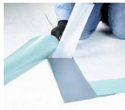
Assemblage par bande adhésive **RENOLIT ALKORPRO BAND**.
