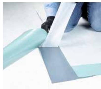
Assemblage par bande adhésive **RENOLIT ALKORPRO BAND**.
