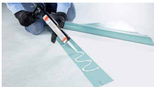
Assemblage par colle mastic RENOLIT CEM 805
