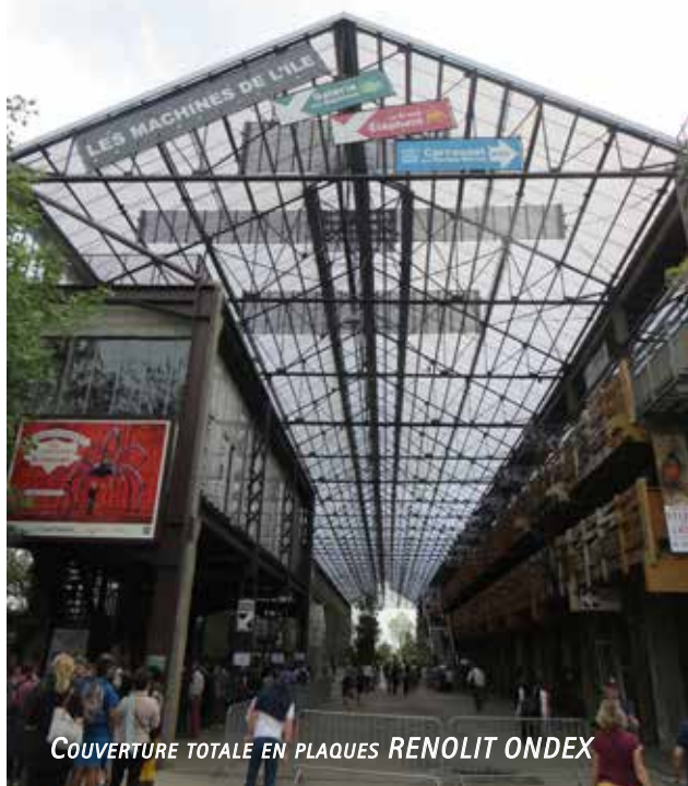
Nefs des halles DUBIGEON sur l'île de Nantes couvertes en plaques RENOLIT ONDEX en 2007 Photo prise en 2016
