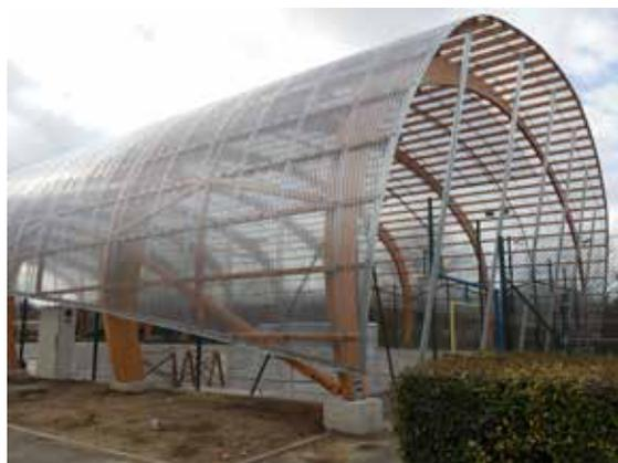
Les longueurs de plaques doivent être suffisantes : > 3 m pour le TO 76/18 et GRECA 70/18 et 8 m pour les autres.
